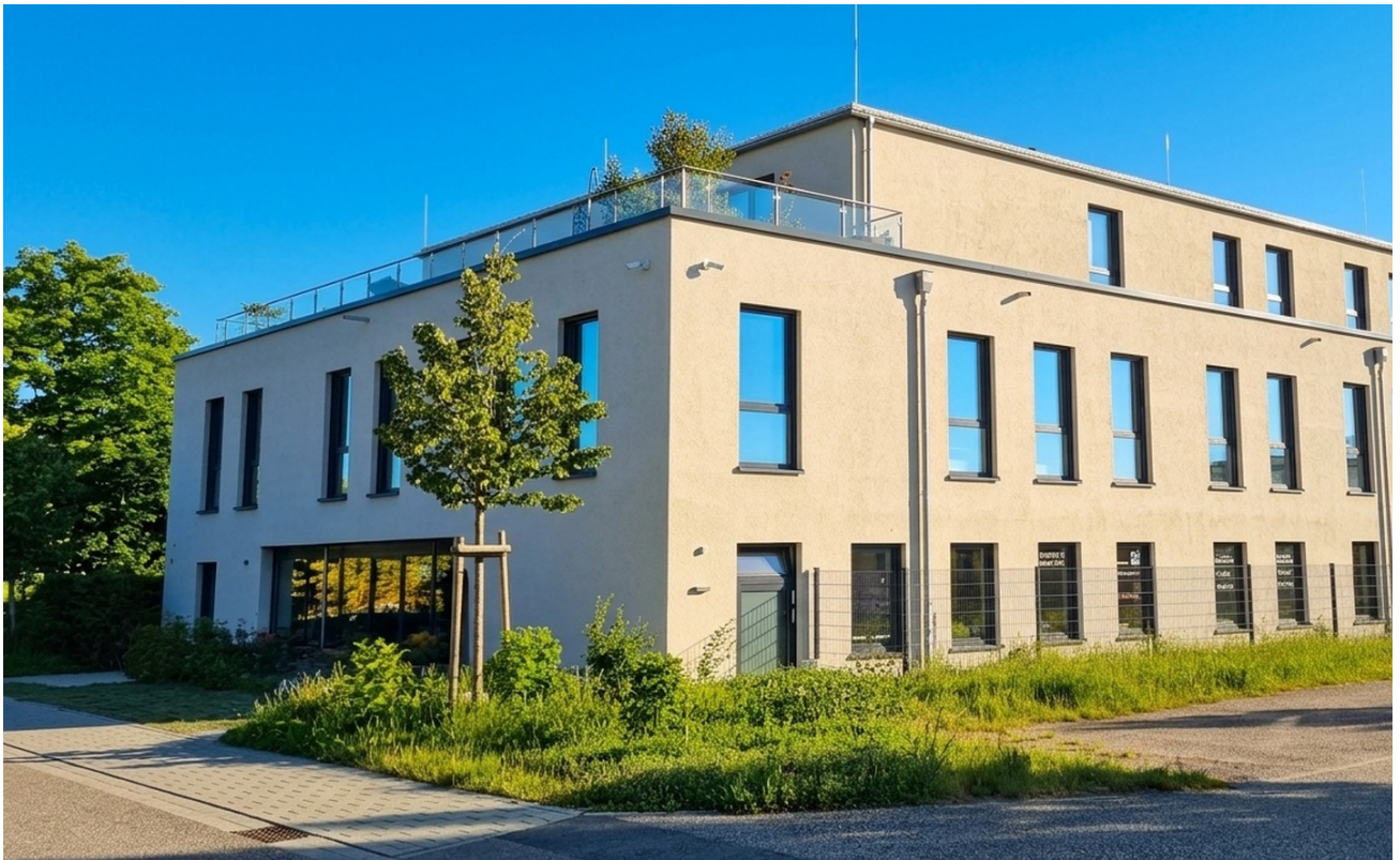
Rückseite des Gebäudes
