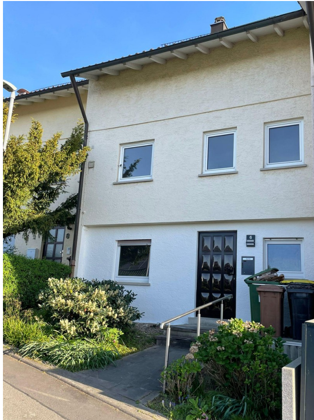
Blick von der Straße
