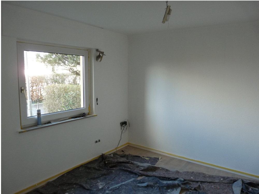
Arbeitszimmer im UG
