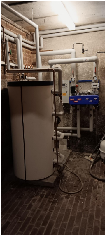
Fernwärmeanschluss
