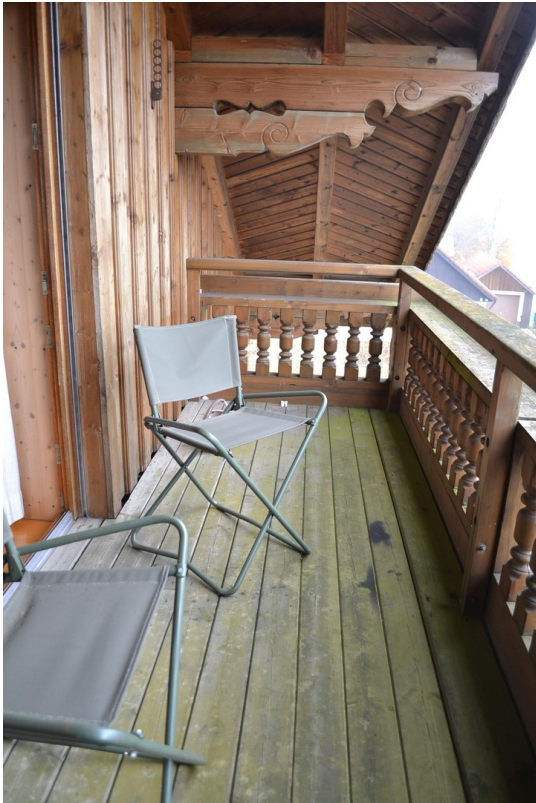
Nord- u. Südseite je DG-Balkon
