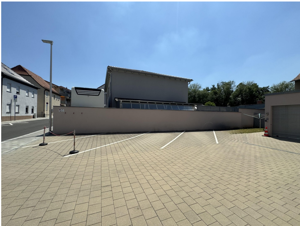
Hof mit Außenstellplatz
