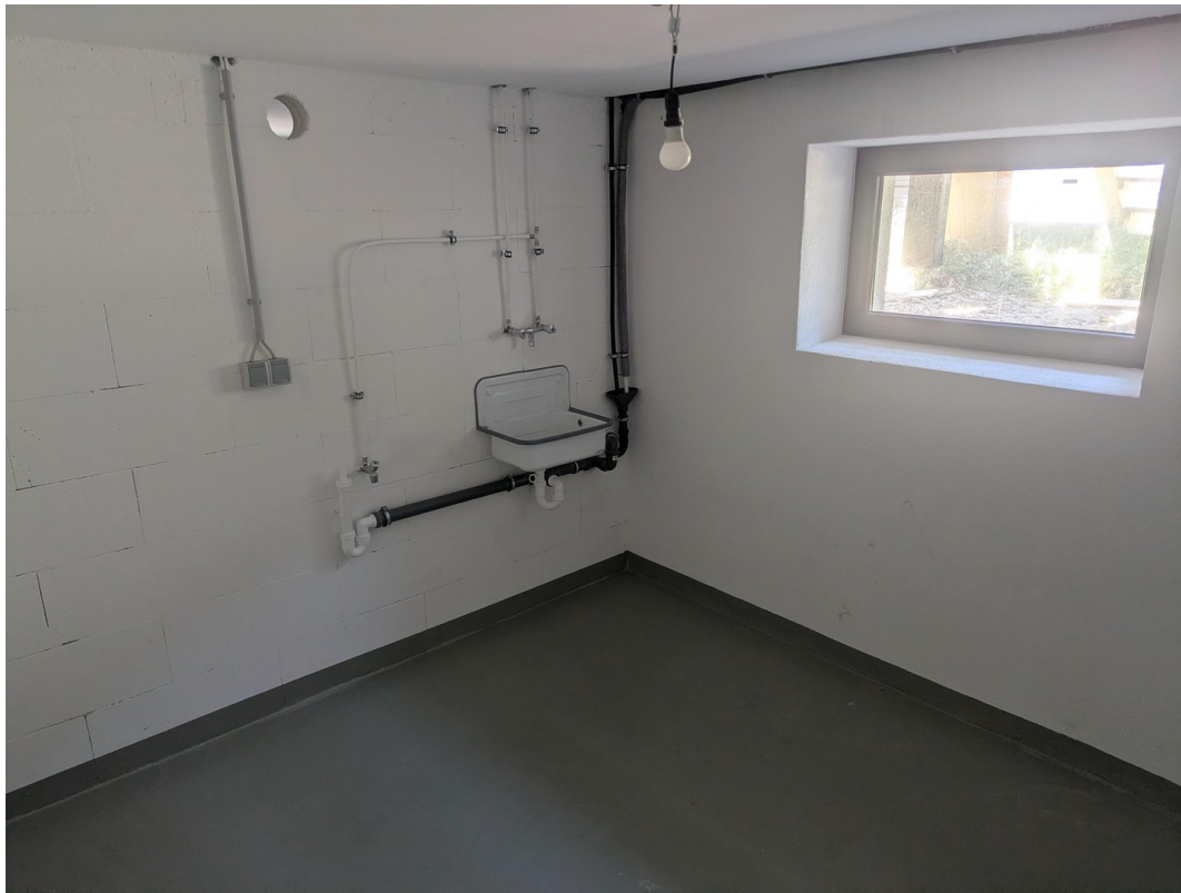
Waschraum im UG
