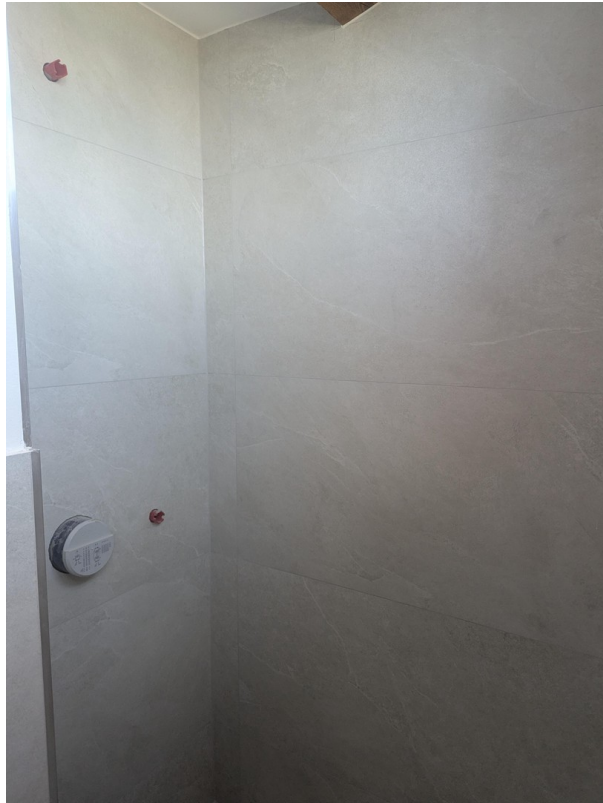
Dusche im Bad 1.OG
