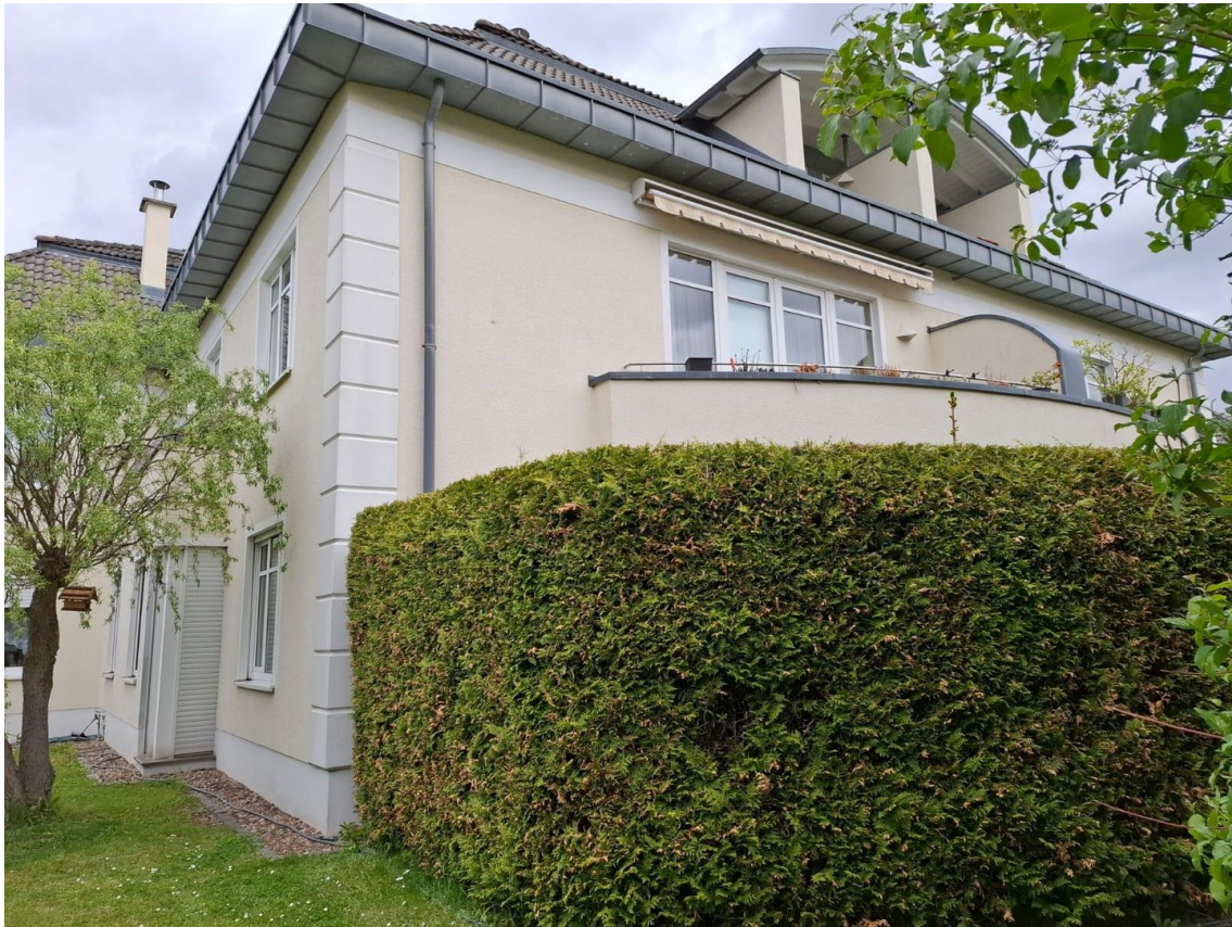
Balkone im 1.OG & DG (links)
