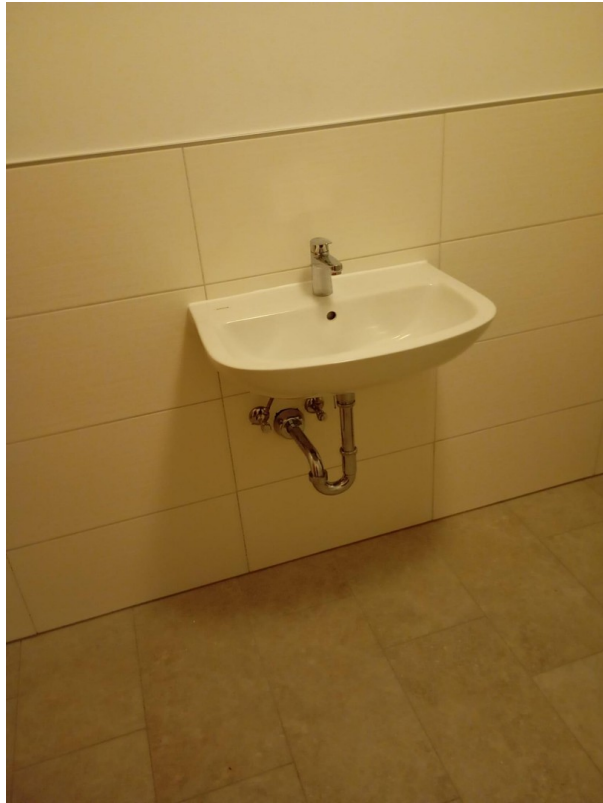
Neues Bad, Waschbecken
