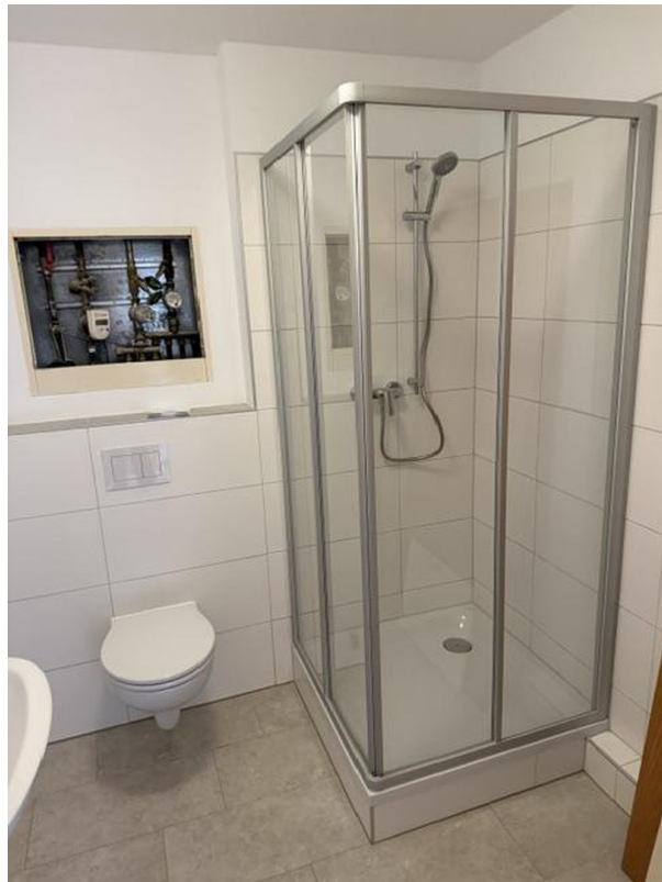
Neues Bad, Dusche
