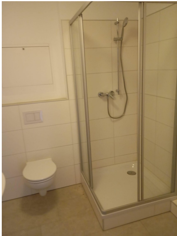
Neues Bad, Dusche
