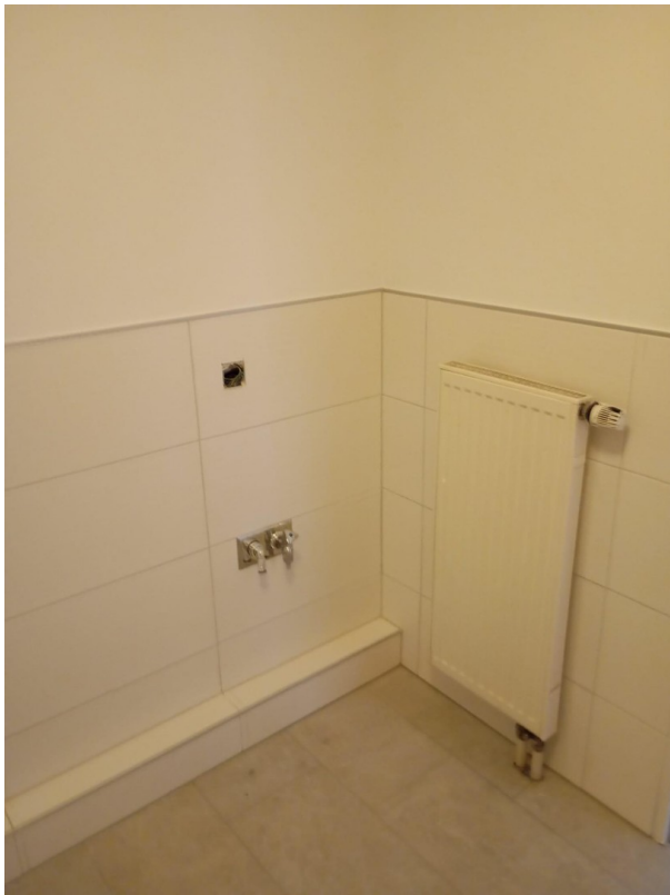
Anschluss für Waschmaschine
