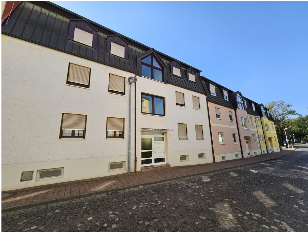
Gebäude von aussen
