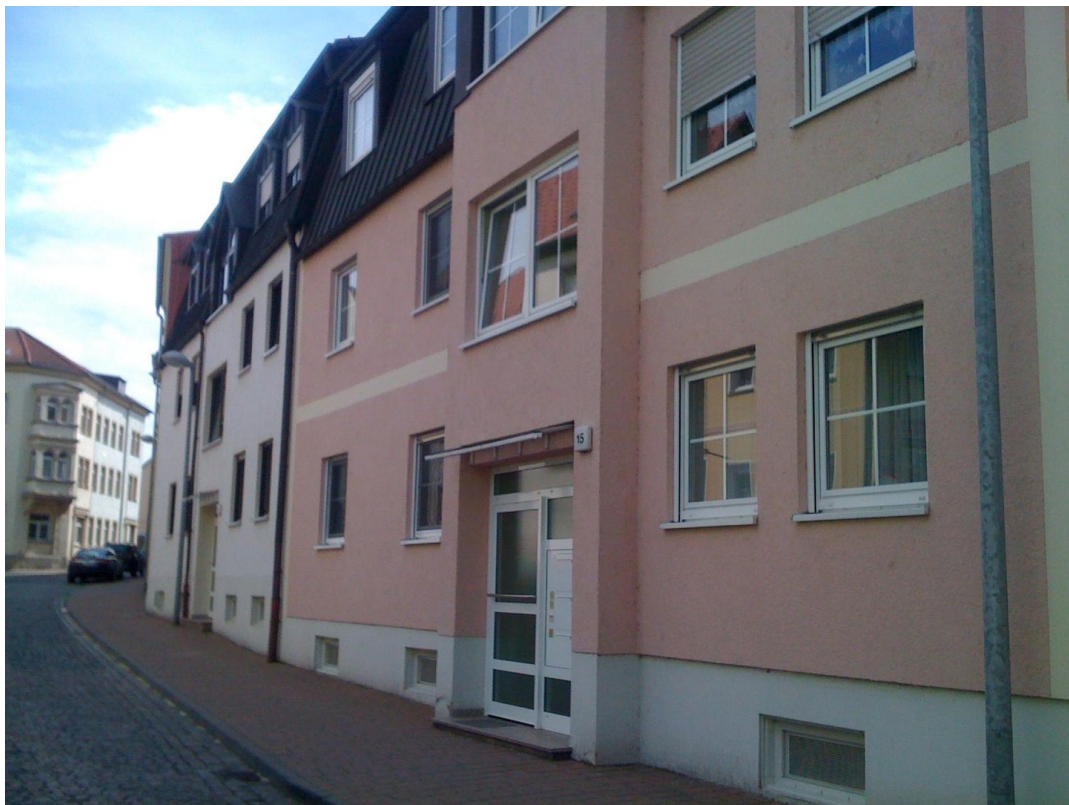
Gebäude von aussen
