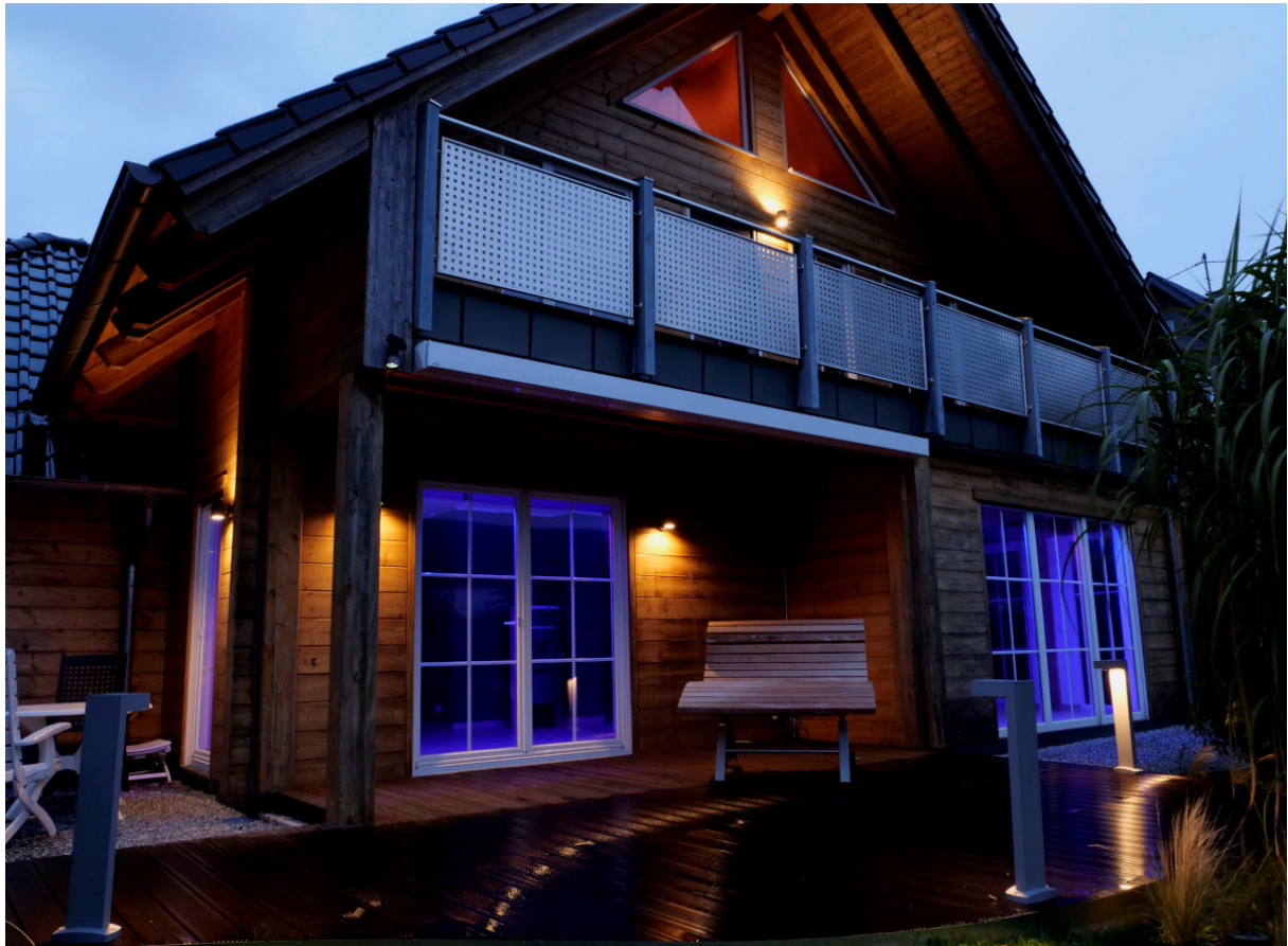
Südwest-Seite mit drei Terrassen und Balkon
