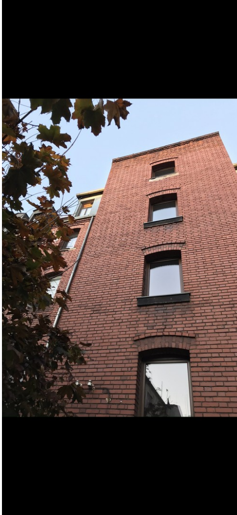
Ansicht Fassade Hinterhof
