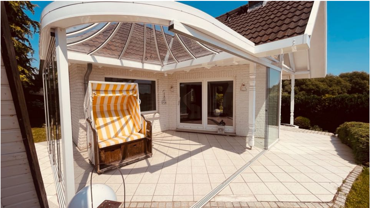
Terrasse, Terrassenüberdachung und Glasschiebeanlage, Bild 06/2026
