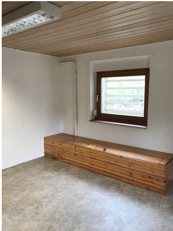
beheizter Raum im Souterrain
