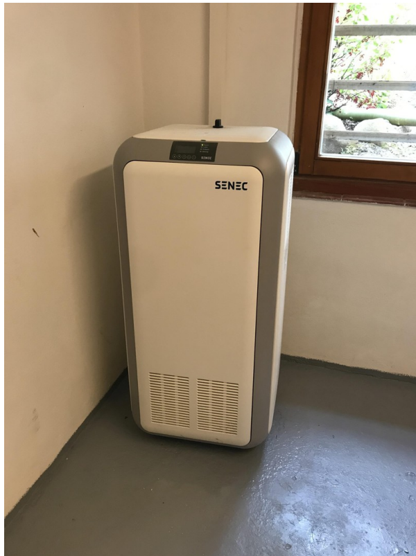
Speicher Photovoltaikanlage
