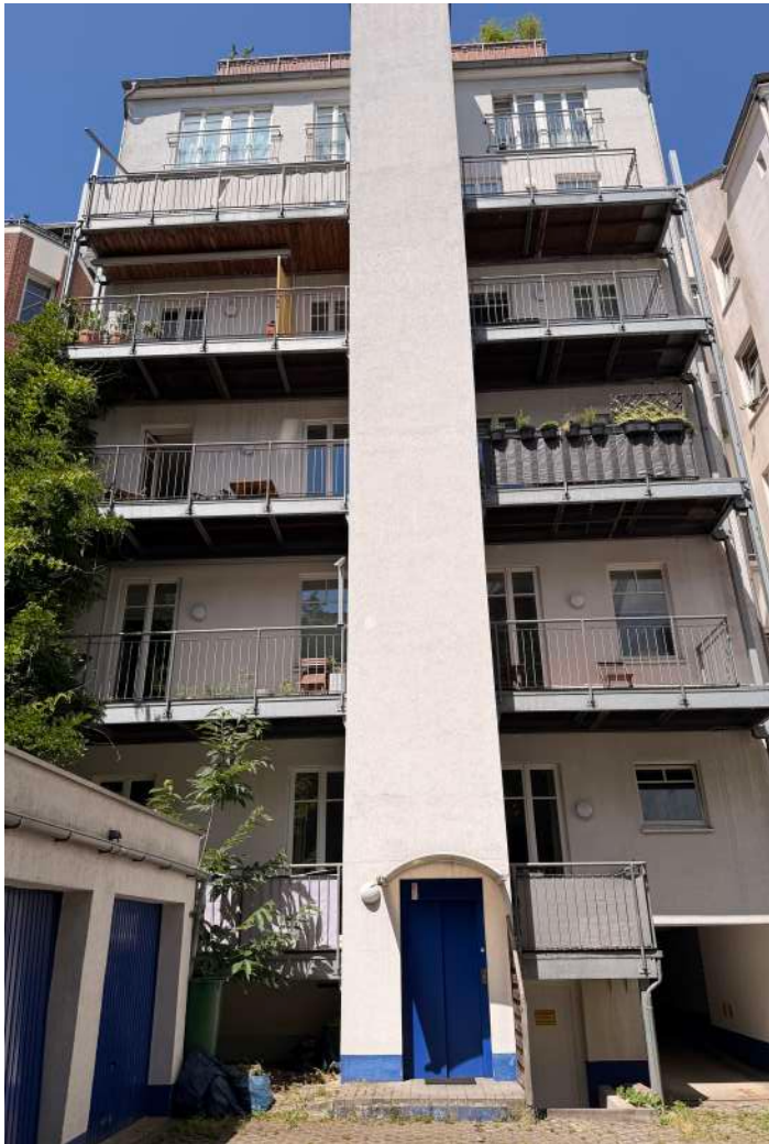
Aufzug mit Direktzugang zur Wohnung im Innenhof
