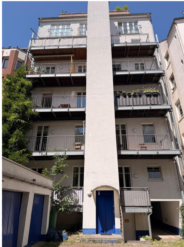
Aufzug von Außen
