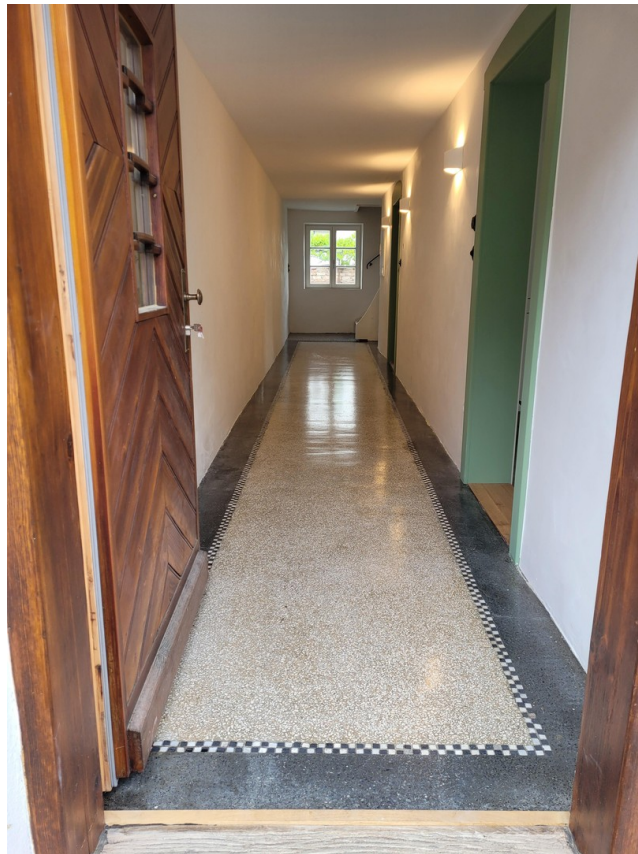
Eingangsbereich mit Terrazzo
