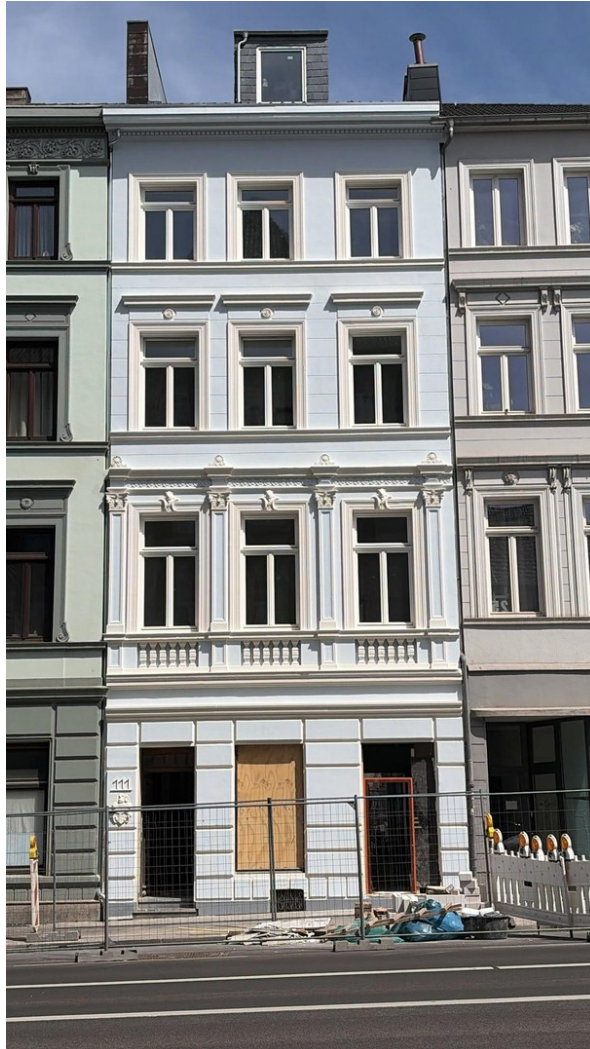
Fassade in Finalisierung
