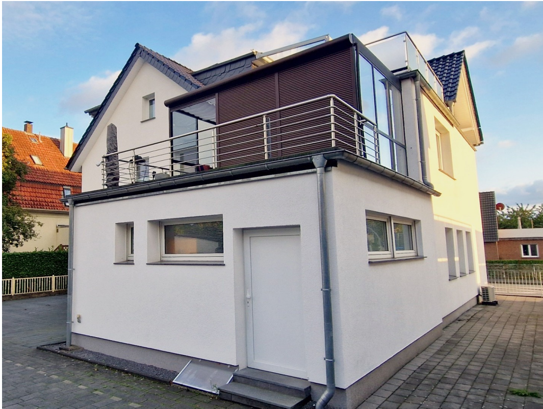
Rückwärtig mit Dachterrasse
