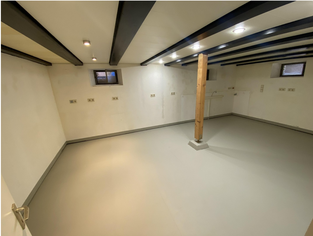
großer Kellerraum m. Steckdosen
