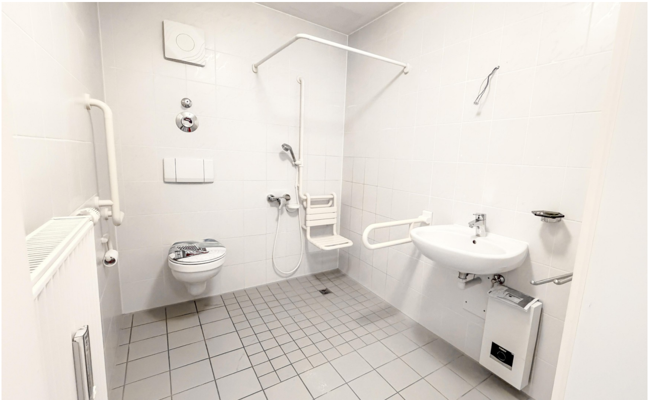
Bad mit bodengleicher Dusche
