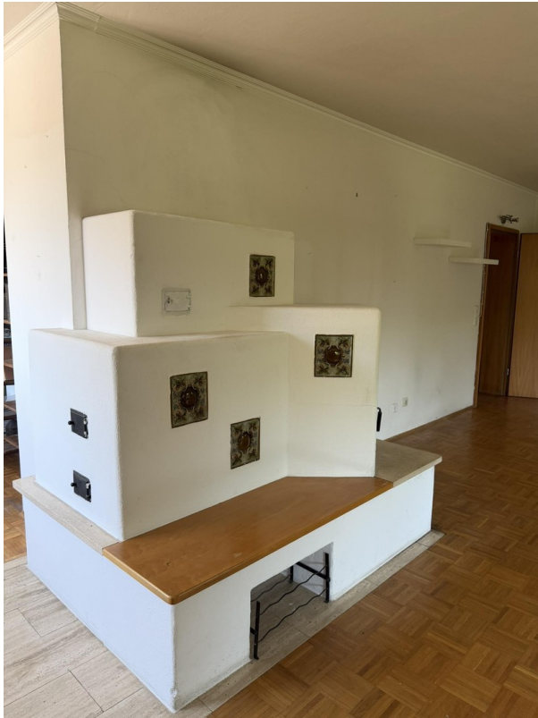
Grundofen im Wohnbereich OG
