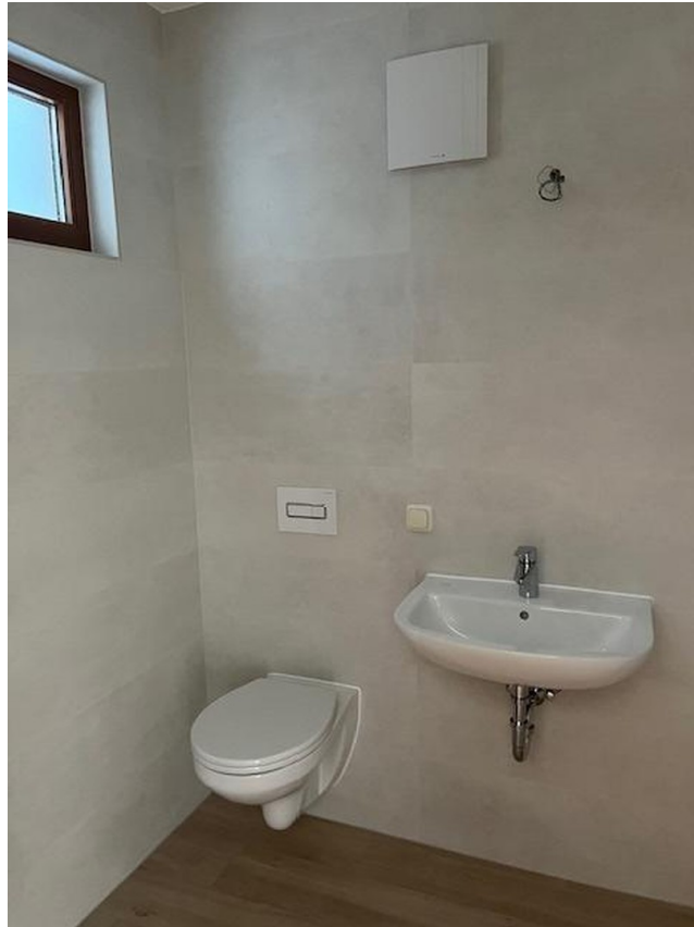
saniertes Bad / WC
