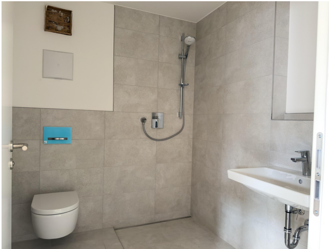
Badezimmer (Duschwand Glas)
