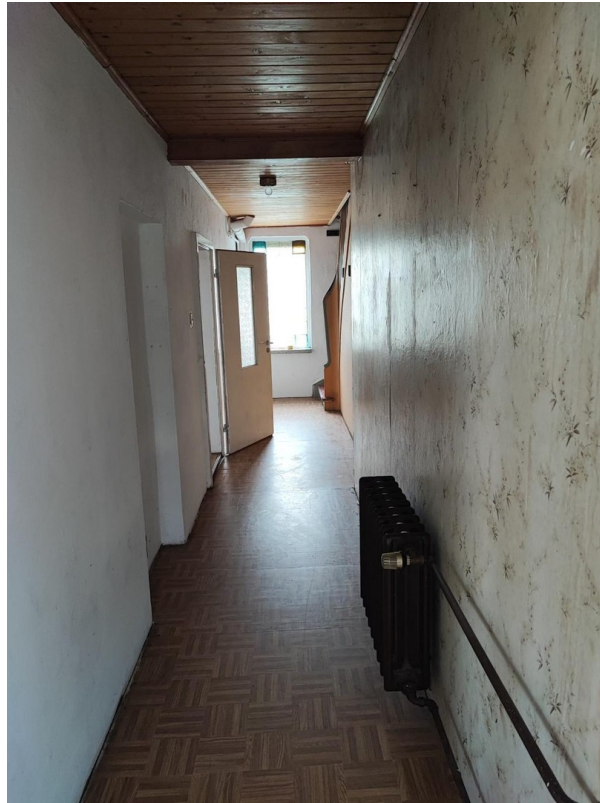
Hausflur hinter Eingangstür
