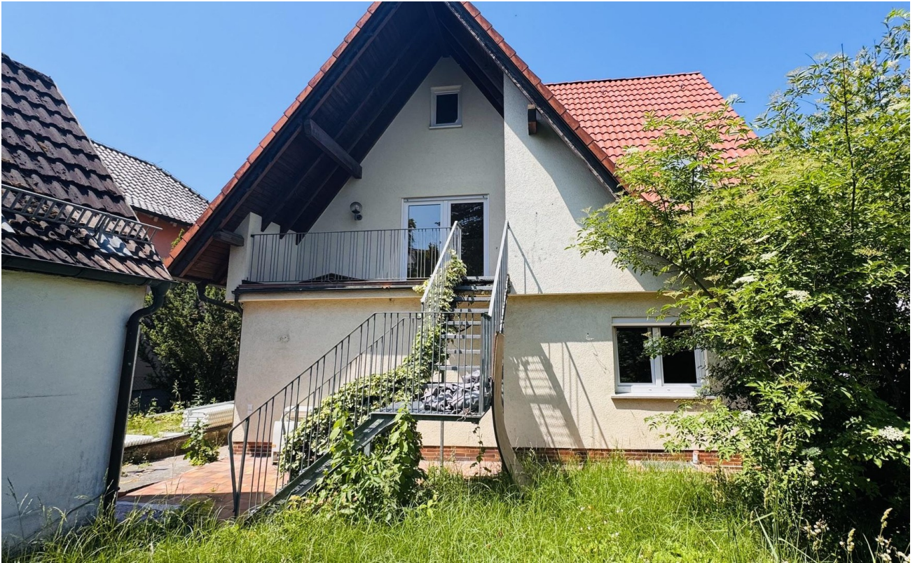
Außeneingang in DG-Wohnung
