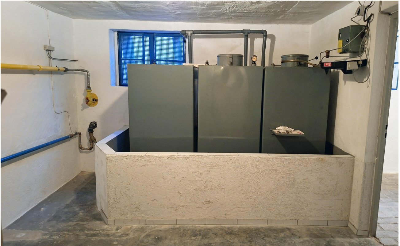
Kellerraum 1 mit Heizöltanks
