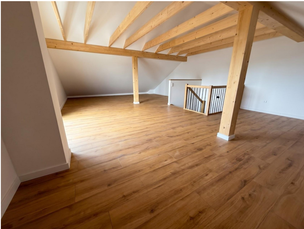
Ausgebauter Dachstuhl 2. OG II
