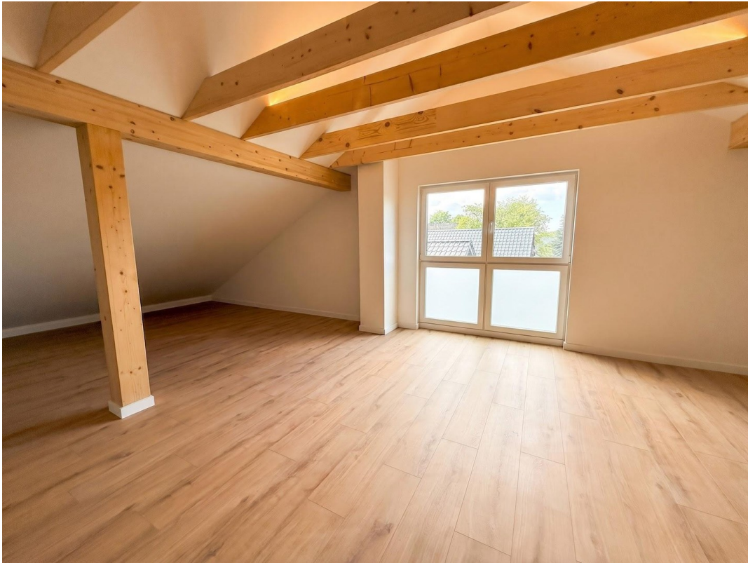
Ausgebauter Dachstuhl 2. OG
