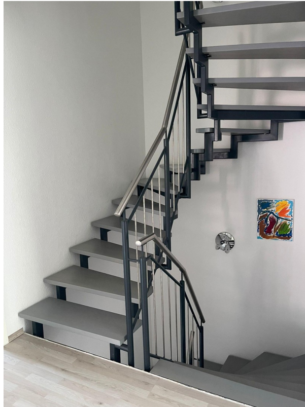
Treppe mit Holzstufen
