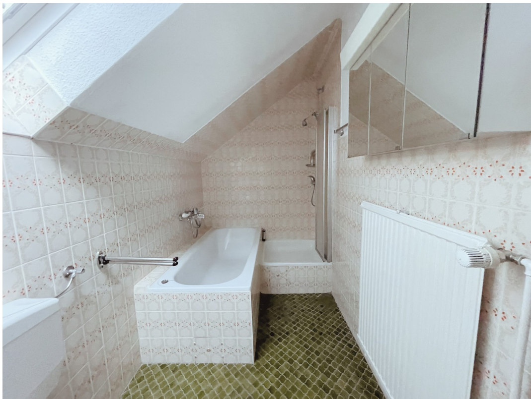
Duschbad - in Sanierung
