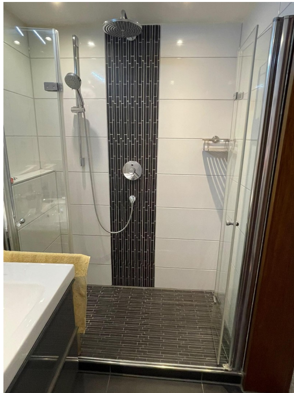
Duschbereich Bad 1. OG
