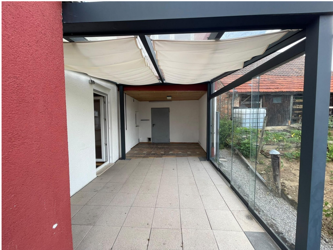
Terrasse EG Glasüberdachung
