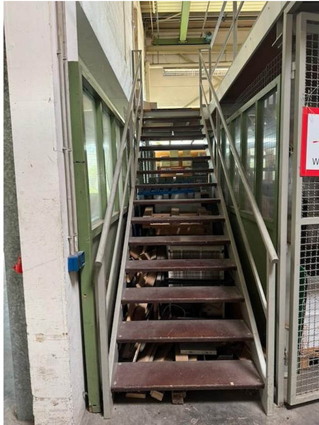
Aufgang Lagerfläche OG
