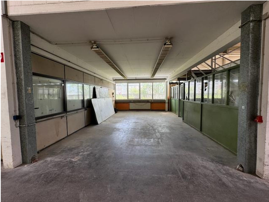
Lagerfläche niedrig EG
