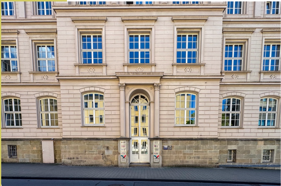
Denkmalgeschützte Fassade des historischen Dürerhauses
