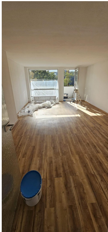
Wohnbereich mit Balkon (1)
