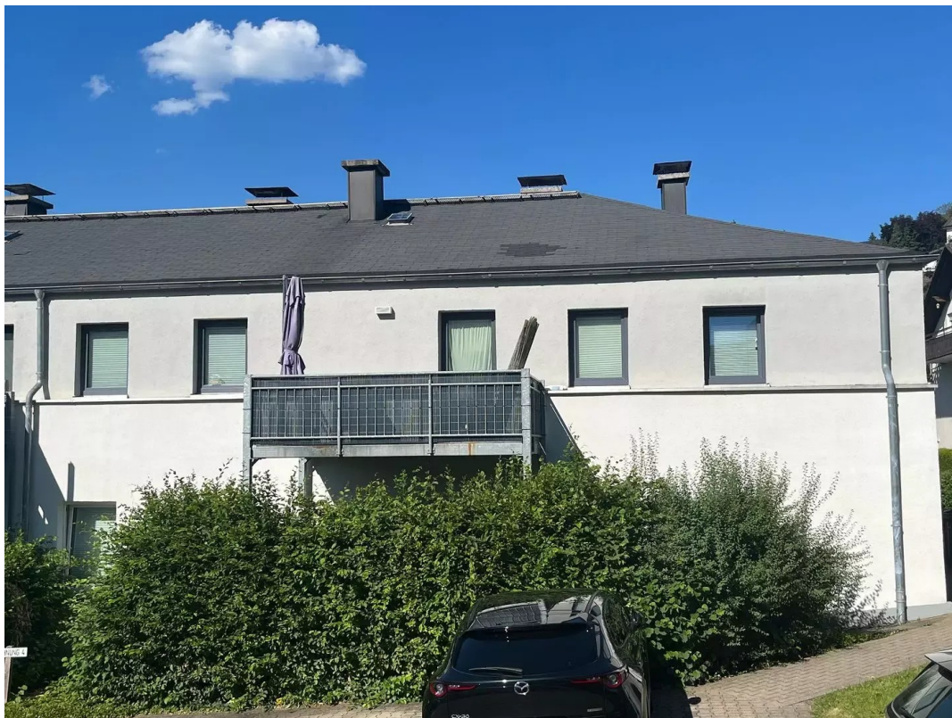
Balkon (EG) geschützt
