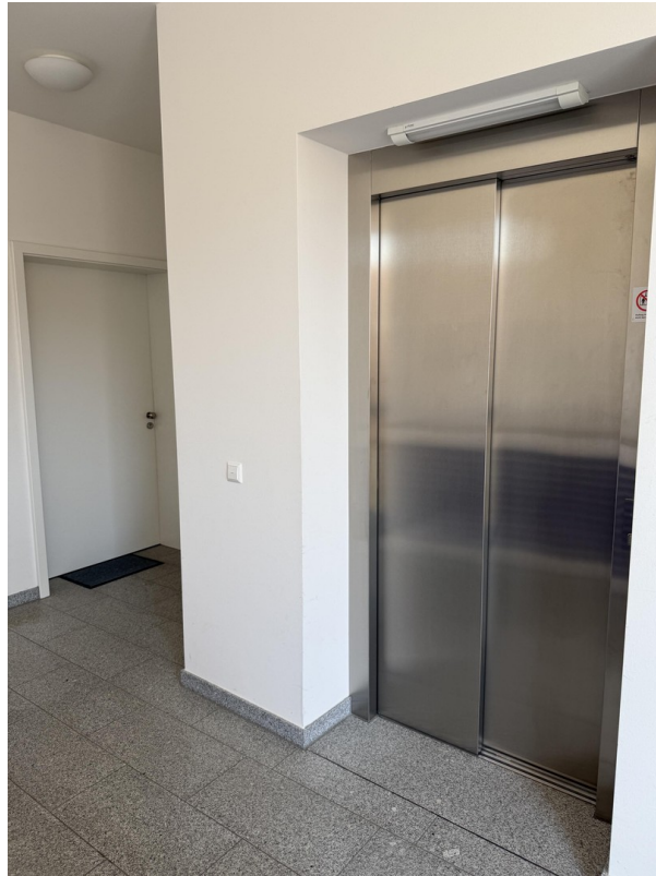
Aufzug und Eingangtüre
