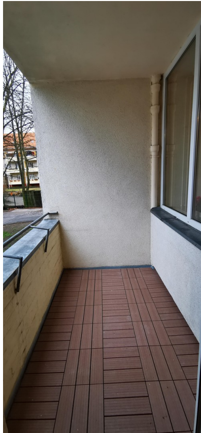
Balkon mit Blick auf den Hof
