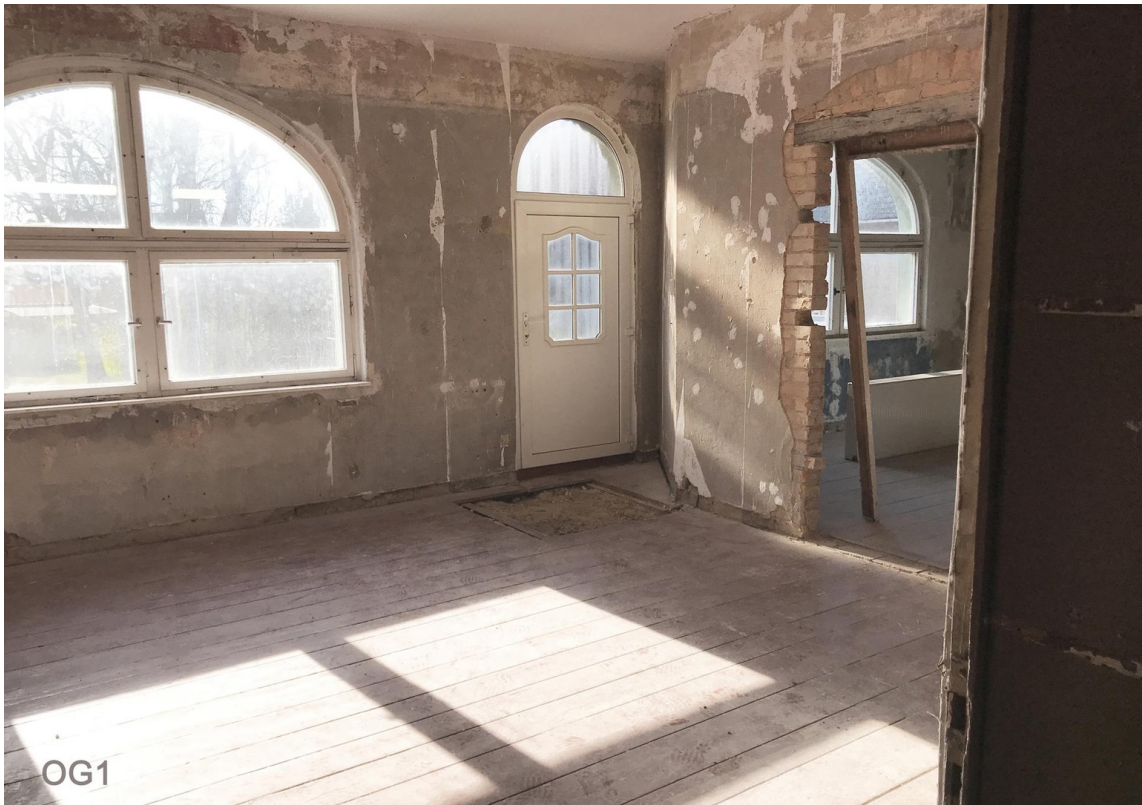
OG zur Strasse
