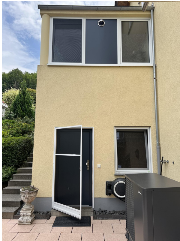
Blick auf Lagerraum/Garage
