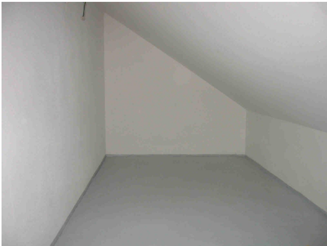
HWR Abstellraum | Strom, LAN
