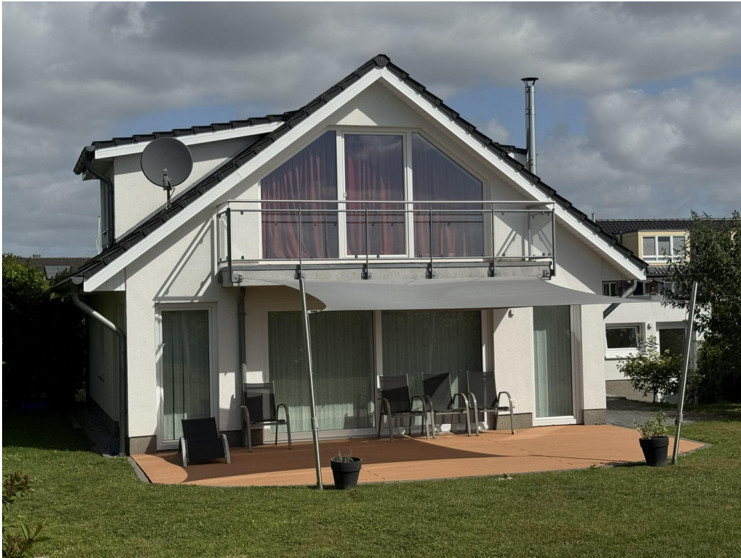
Südseite und Terrasse
