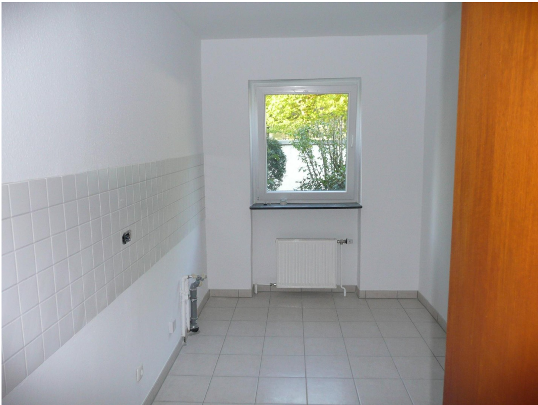
Küche - Blick zur Stichstr.
