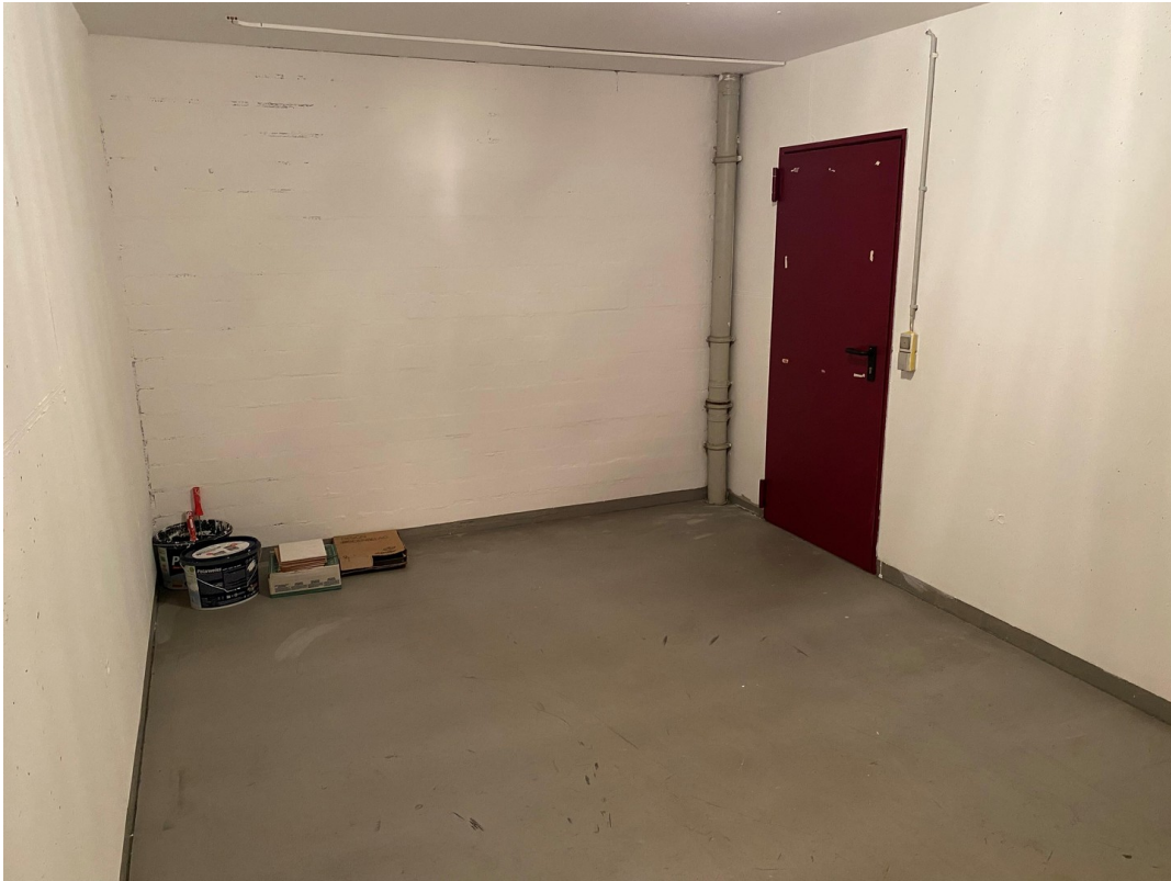
großer Kellerraum mit Fenster
