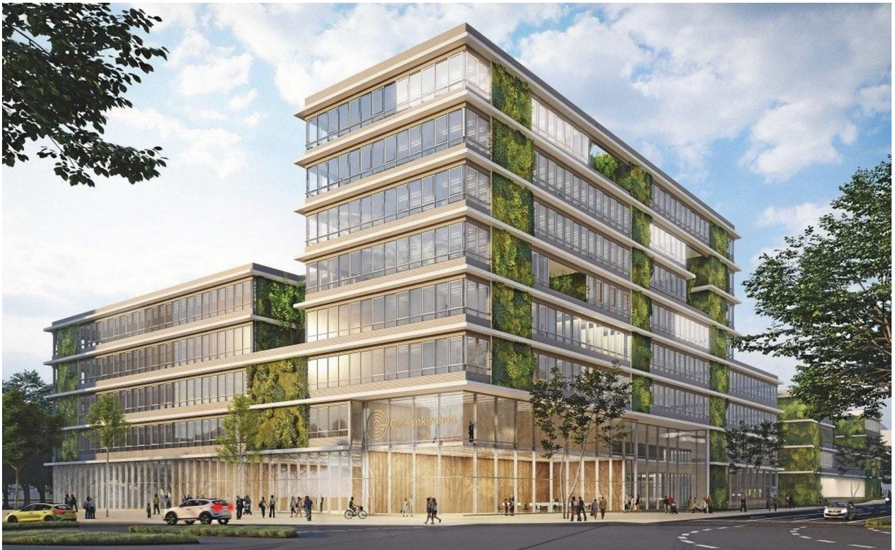
Ansicht nach Fertigstellung
