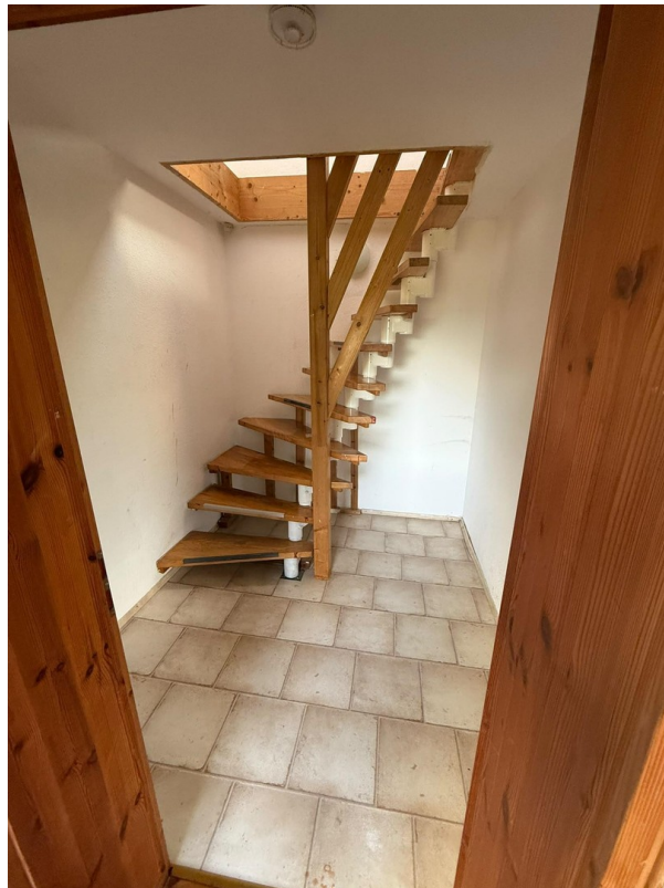
Aufgang ins Dachgeschoss
