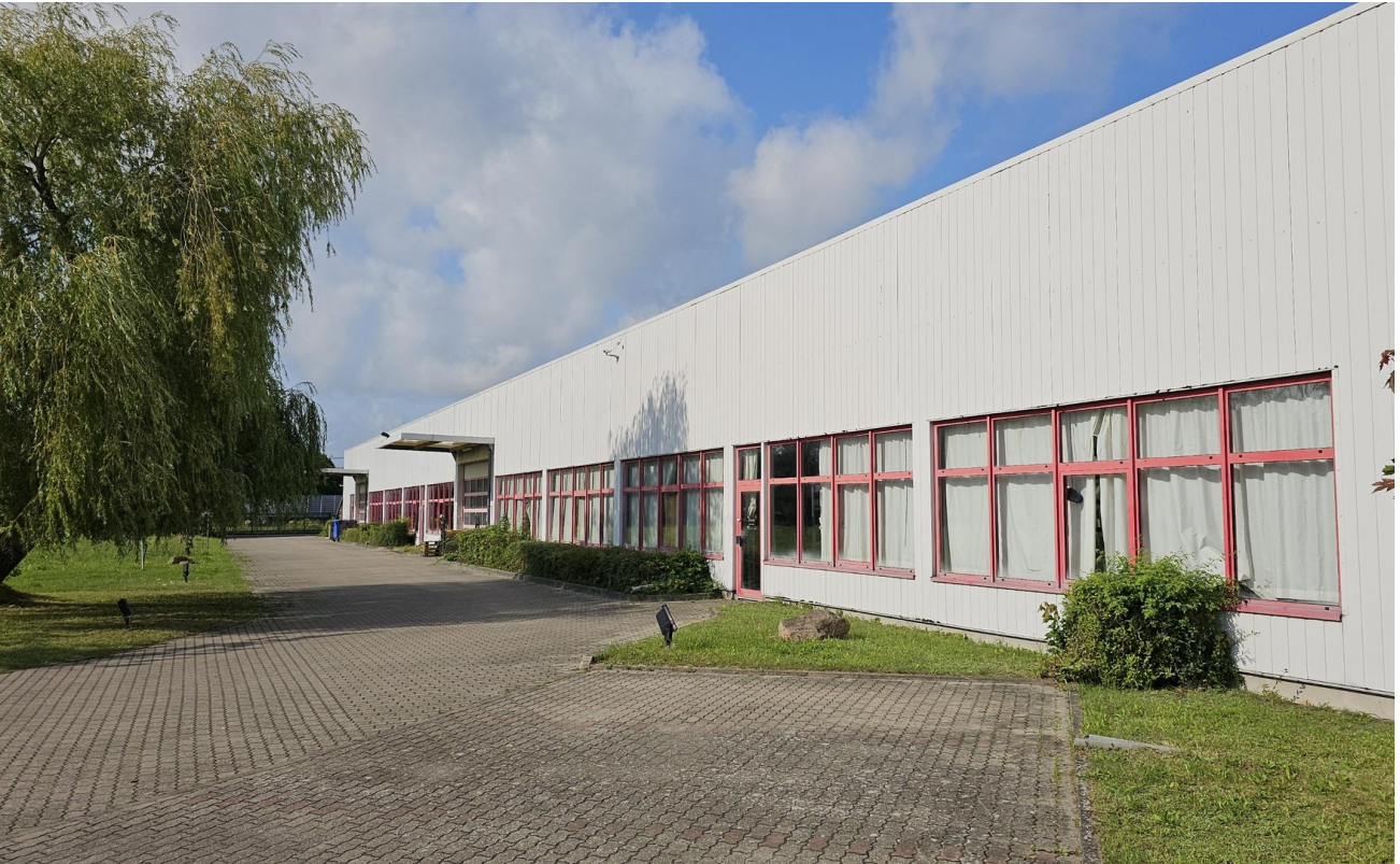
Zufahrt zu den 2 Hallentoren
