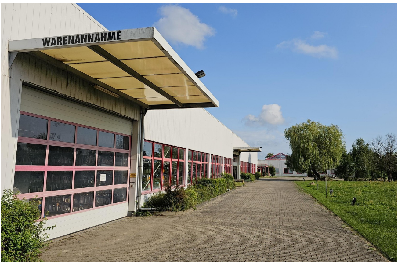
Blick auf Halle und Büro
