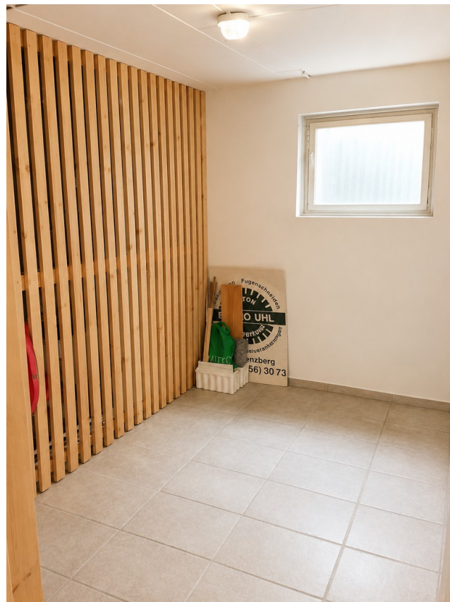
Trockener Keller mit Strom
