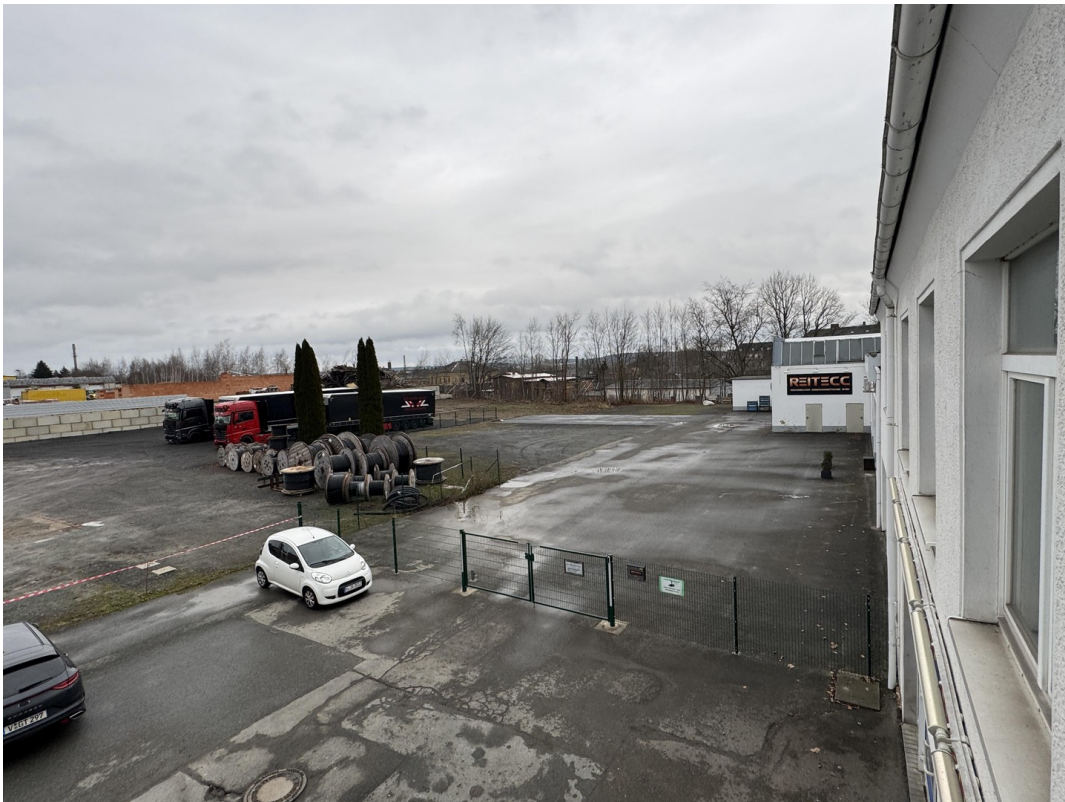
Außenfläche hinter dem Zaun
