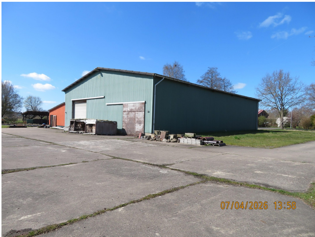
große Halle Ost Ansicht
