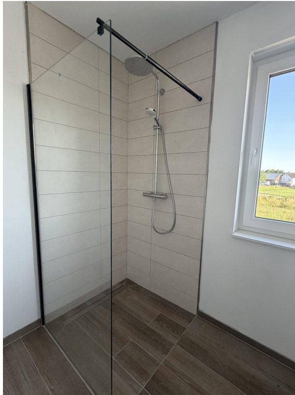
Bad, ebenerdige Dusche
