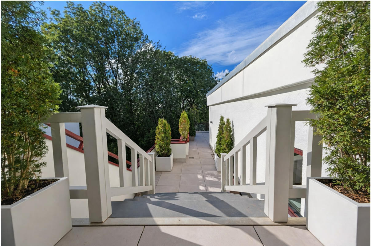
Treppe zur Master-Dachterrasse
