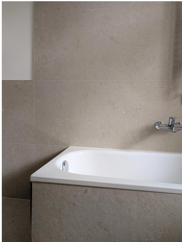
Neue Fliesen & Sanitäröbjekte
