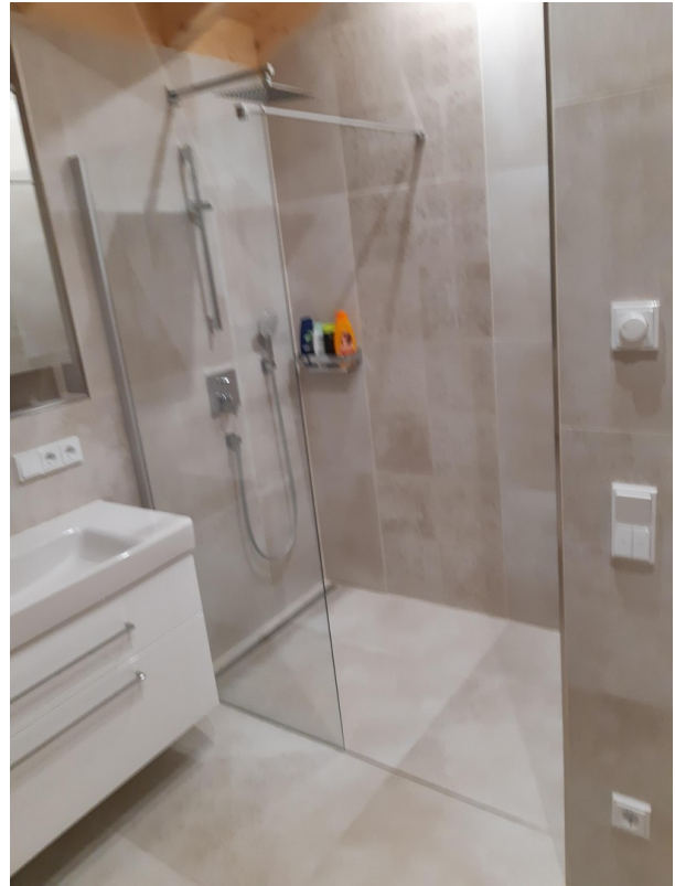
Badezimmer im OG-1
